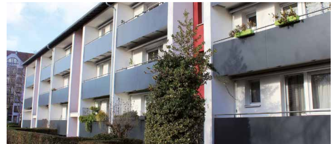
Sennteichplatz 1-5, Neckarau Die in Mannheim-Neckarau gelegenen zweigeschossigen Häuser verfügen über eine Photovoltaikanlage auf dem Dach.
