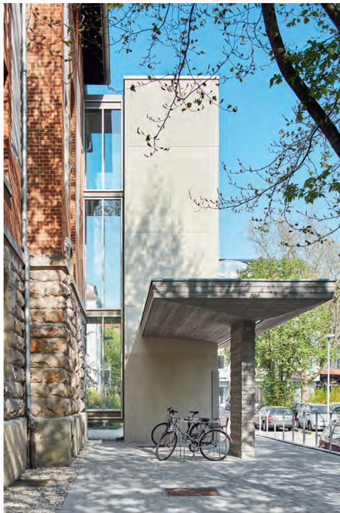
Bild 3. Aufzugsturm mit Vordach
