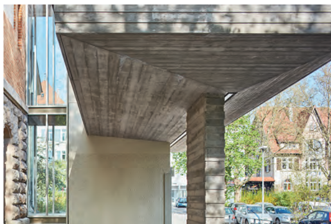
Bild 4. Vordach aus Sichtbeton
