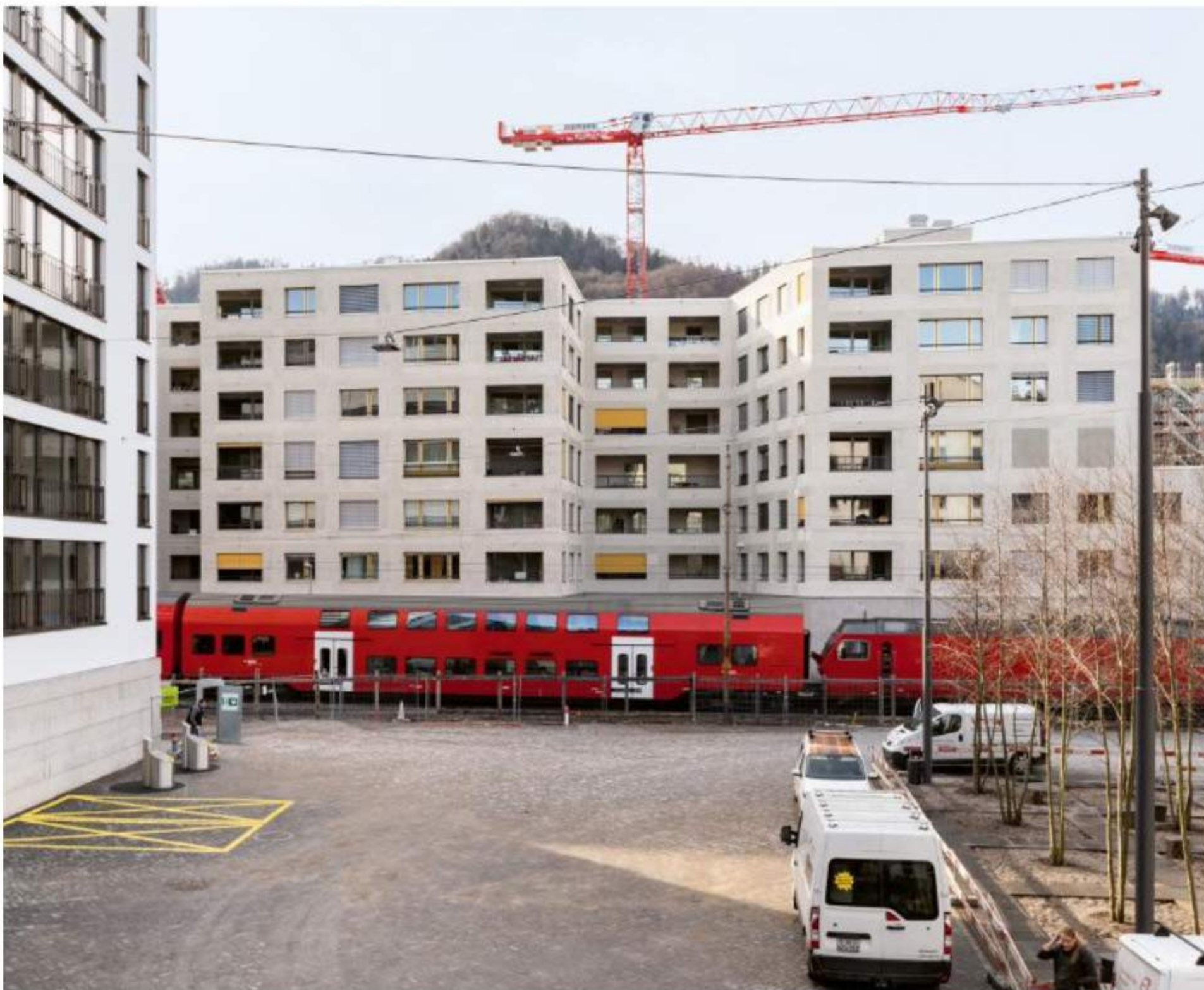
Asphalt von Tür zu Tür: Die Allmendstrasse wurde nicht als Quartierboulevard ausgebaut, sondern als Schnellstrasse. Abbiegespuren beschneiden das Trottoir vor dem Genossenschaftshaus von EM2N.
