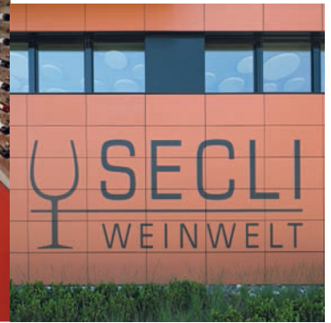
Fassade mit Firmenaufschrift
