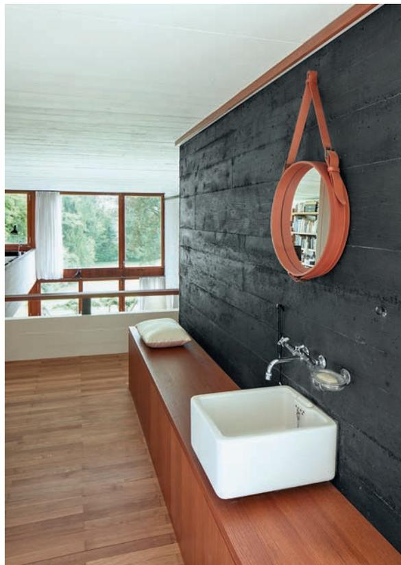
Links: Der Kern aus Cheminée und Installationsschacht besteht aus Sichtbeton, anthrazitfarben lasiert.
