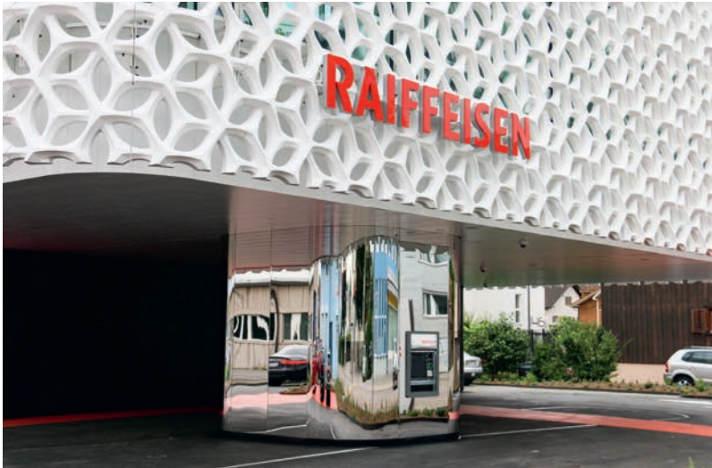
Die Module wurden vorgefertigt. Die grösste Herausforderung war daher die perfekte Montage. Es gab keine Masstoleranzen.
