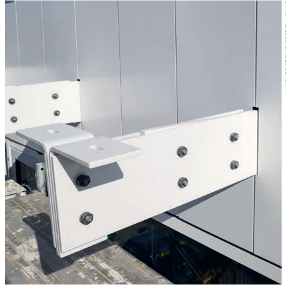
Fassadenkonsole, für die Aufnahme der Betonelemente.
